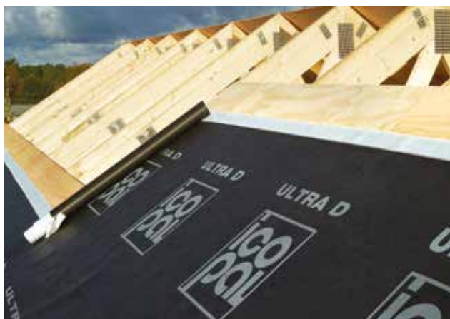
Icopal Ultra D - diffusjonstett asfalt underlagsbelegg.
